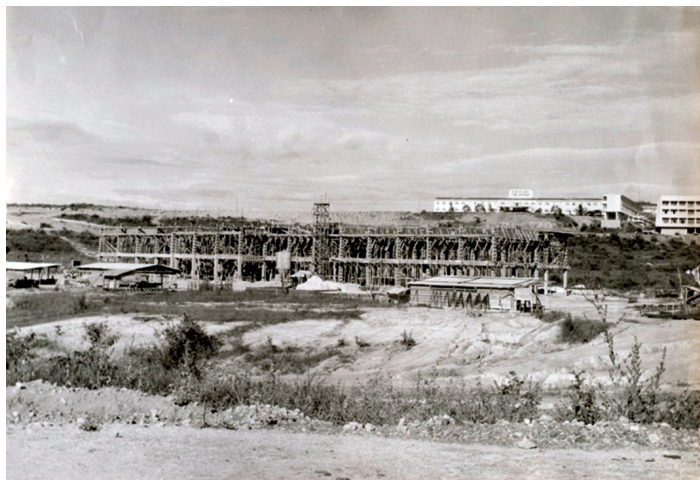
Obra de construção do Coltec, nos anos 1960
